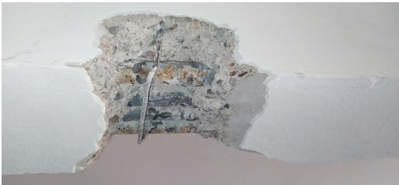
Foto 5 – Výztuž v trámech
