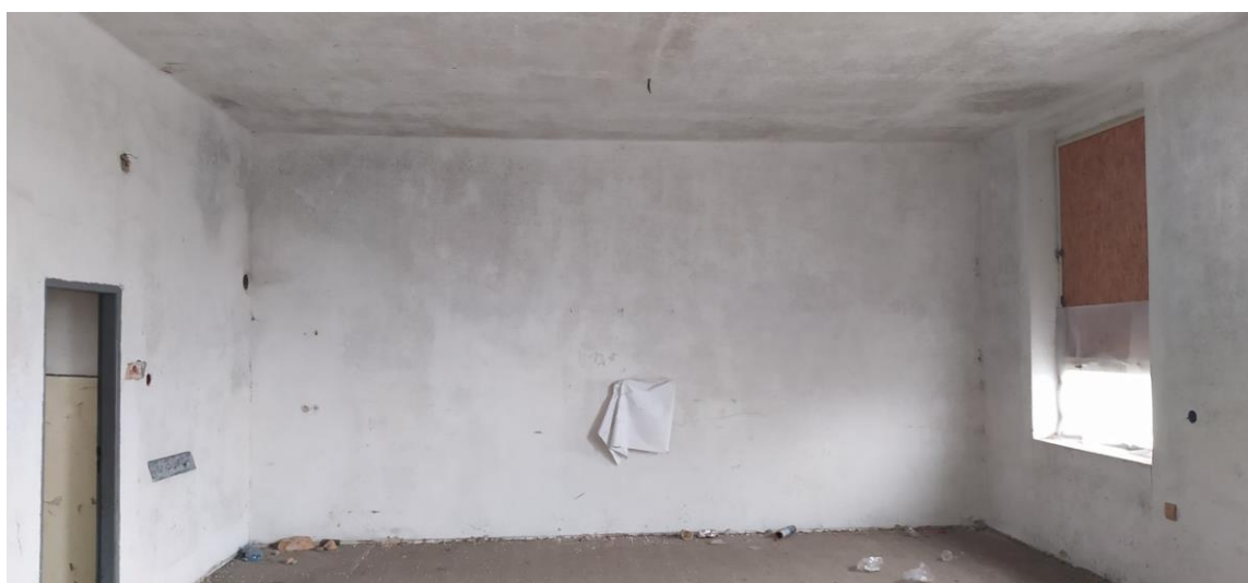
Foto 3 – Strop nad 2NP
