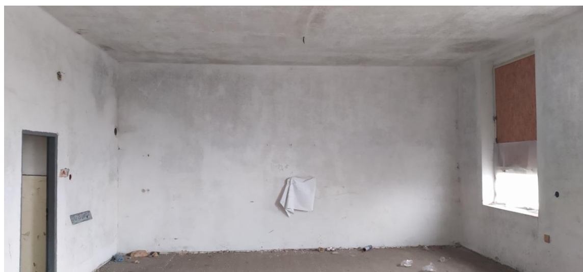
Foto 3 – Strop nad 2NP
